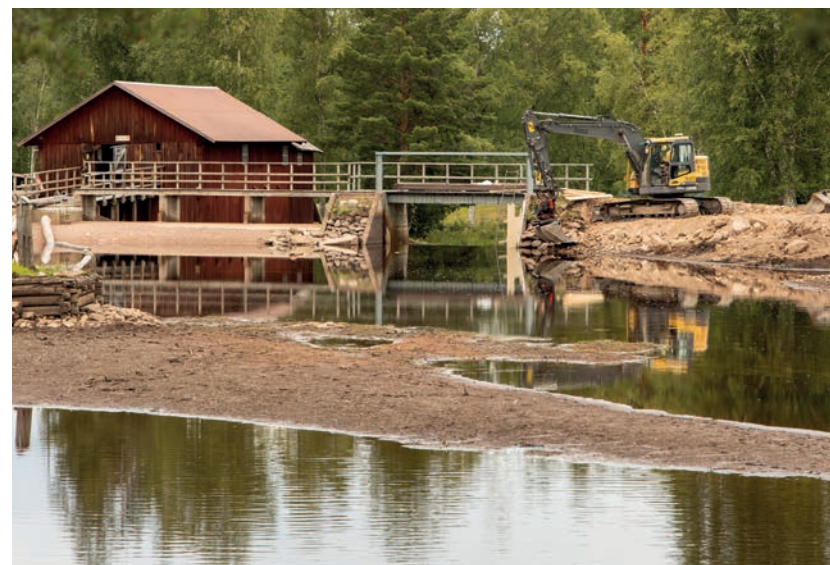
Reparation av dammen i Mångberg. Foto: Torbjörn Nääs
