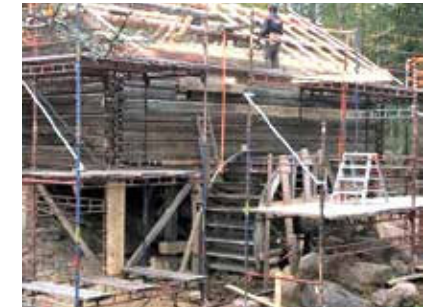
Montering takreglar östra takhalvan
