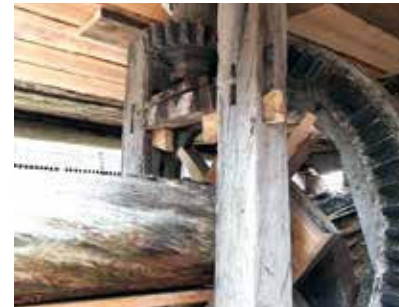
Kugghjulet på axeln från vattenhjulet som för upp rotationen genom golvet.
