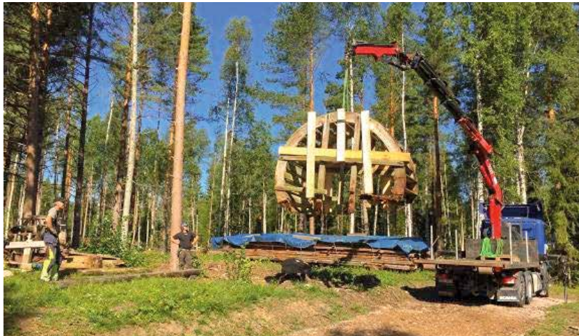
Vattenhjulet förstärktes provisoriskt för att kunna flyttas
