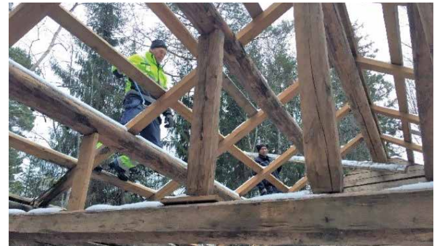
Demontering av takreglar
