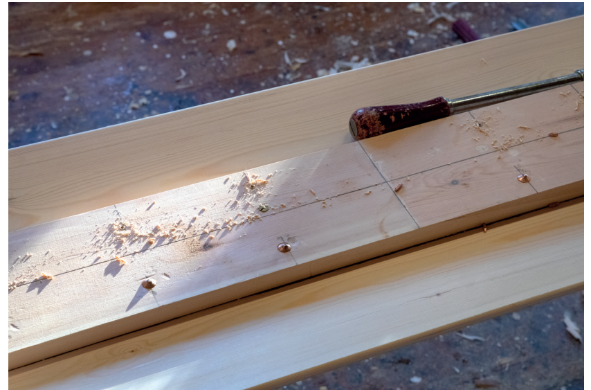
Bordläggning påbörjas. De första borden kräver extra noggrannhet.
