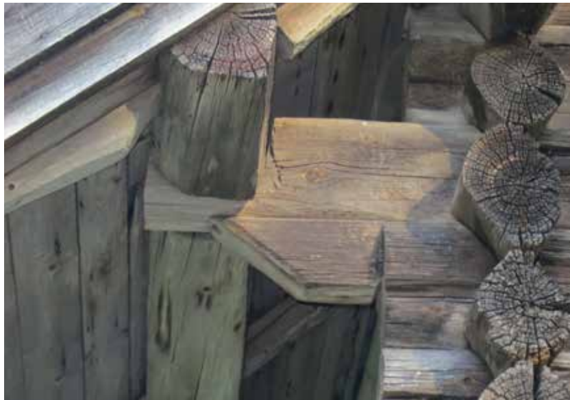
Väggdetalj, upplag för balk. Foto: Sture Samuelsson
