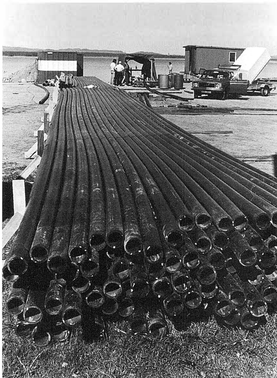
Bild från Mora kommuns vattenprojekt för Sollerön. 6 km dubbla ledningar av plast lades på sjöbotten från Nusnäslandet och till Sollerön. Längderna svetsades samman och matades ut sedan de försetts med betongtyngder var 5:e meter. Ledningen förhöll sig flytande fram till det att vatten pumpades in och tyngderna drog ner den till botten. Största djup mellan Nusnäs-Sollerön är cirka 100 meter. Foto: Lars-Erik Klockar
