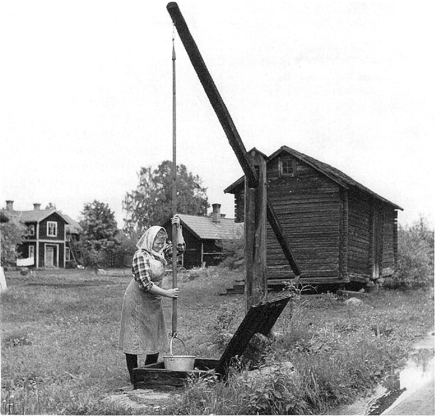
Amusull Stina (f. 1893) vid gammal brunn i Bengtsarvet. Brunnen utrustad med "vindstång" (brunnsvåg) där bakre delen av stången är försedd med tyngd för att den vattenfyllda hinken lättare kan hivas upp från djupet.
