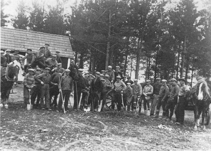
En del av arbetsstyrkan vid idrottsplatsens byggande.
