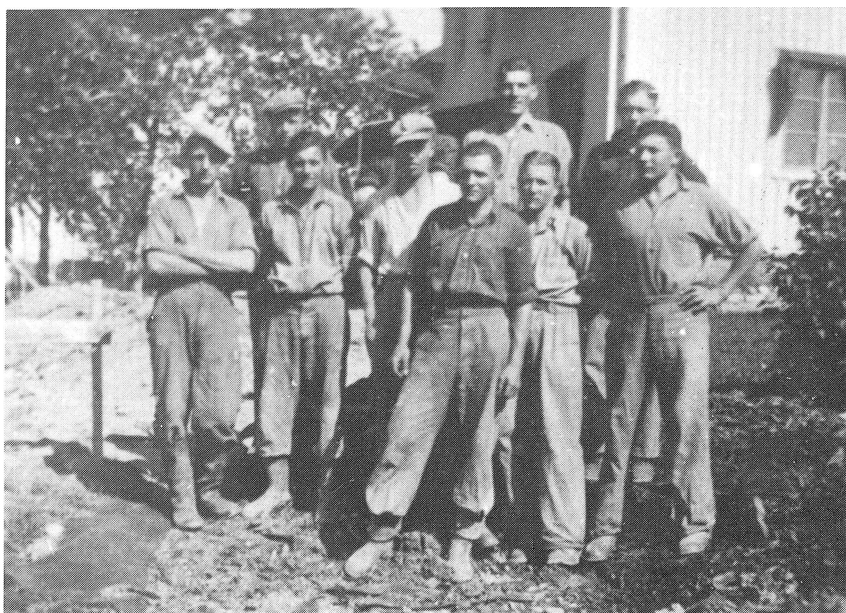
En del av arbetslaget vid dikesgrävningen vid Rundviksverken. I främre raden Ryss Albert, Svarvkitt Rune, Bom Axel. I bakre raden, den andre från vänster, Trapp Nils.
