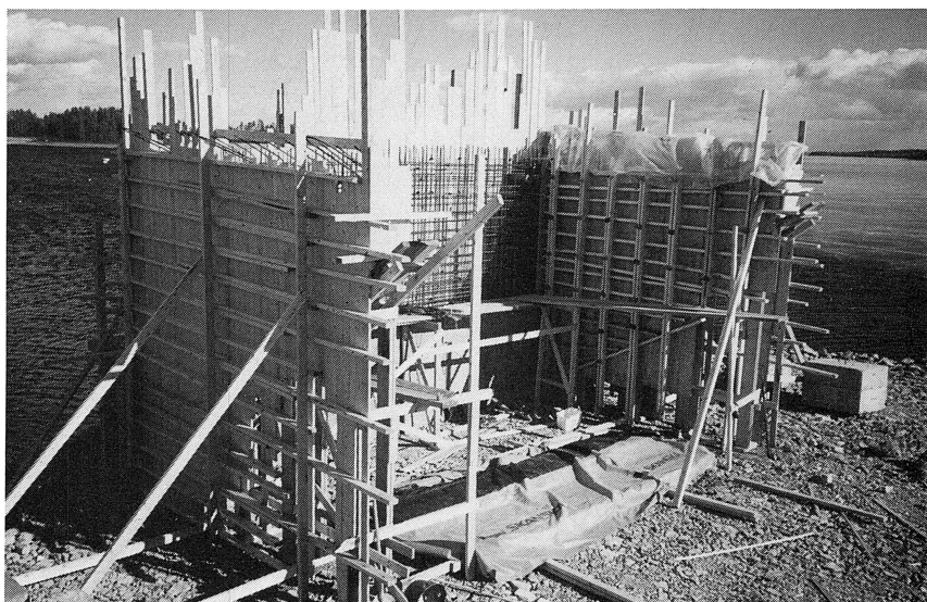
Gjutformar för brofundamentet byggdes. Bilden visar västra brofästet.
