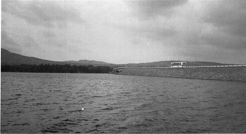
Den nya bron står färdig att tas i bruk. Bilden, tagen från båthamnen på Lerön, visar att schaktmassorna höjt banken vid brofästena väsentligt.
