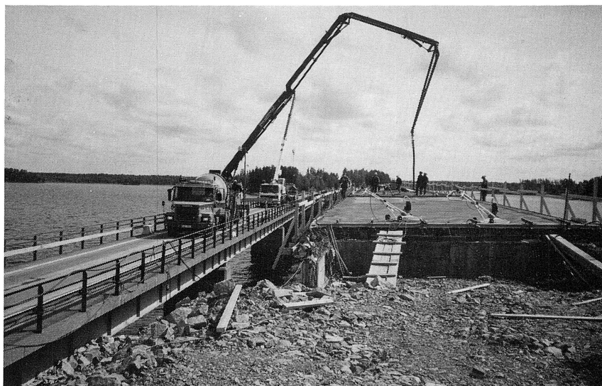
Från en betonglastbil på gamla bron sprutas betongen över till den nya bronsvägbana. Gjutningsarbetena har här nått det västra brofästet.
