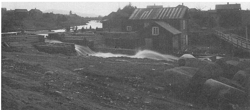
Ryssån med Stora Kvarnen vid nedre fallet och nedströms stenbron. Kvarnen spolades bort under den stora vårfloden år 1916.
