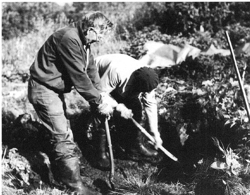
Arbetet med rensningen har påbörjats. Henry Persson och Evald Håkansson.
