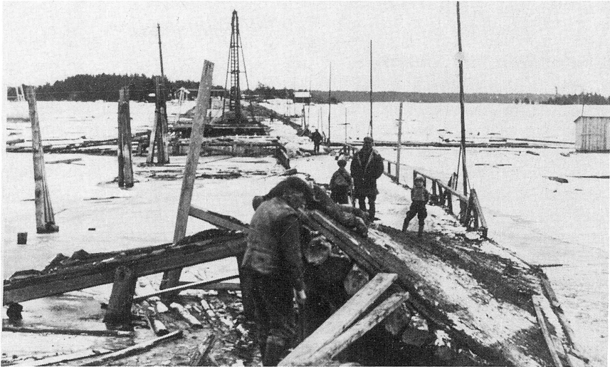
Brobygget förberedes med pålning
