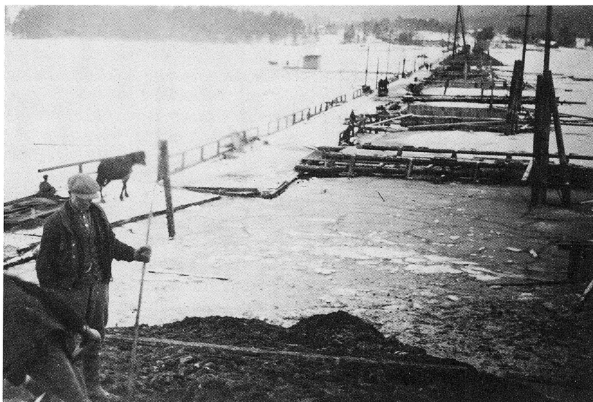
Vinterbild från inledningsskedet av brobygget. Brofundamenten har börjat gutas. En timmerkörare med kalkdon är på väg västerut mot fastlandet. I förgrunden pågår stakningsarbeten vid östra brofästet.
