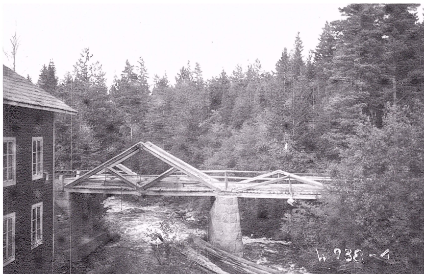
Landsvägsbron vid Mångbro.
