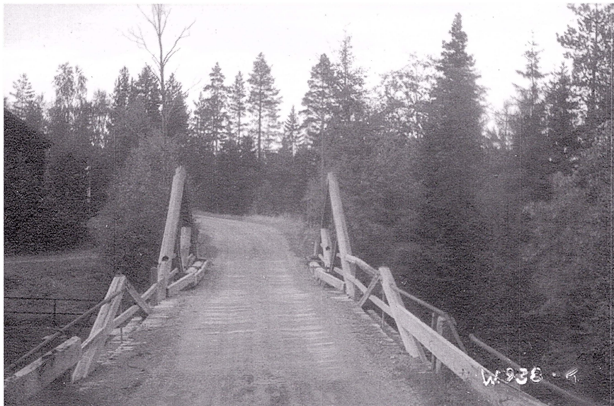
Landsvägsbro vid Mångbro.
