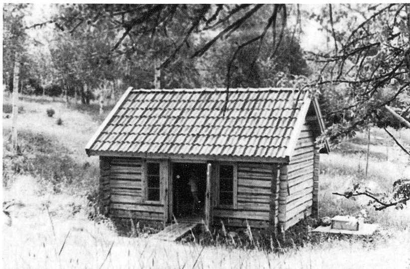
Mejeriet efter restaureringen hösten 1993. Byggnaden frilagd och försedd med nya undre stockvarv samt tegeltak. Den nya brunnen skymtar till höger.
