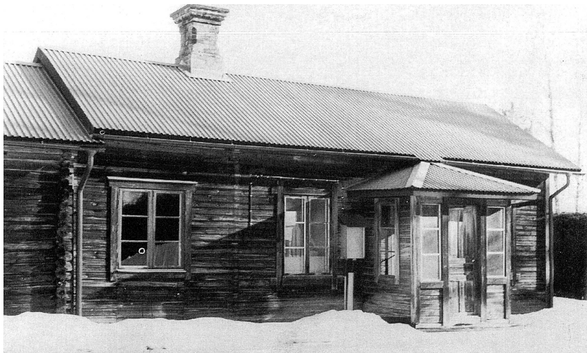
Bostad och snickarbod.
