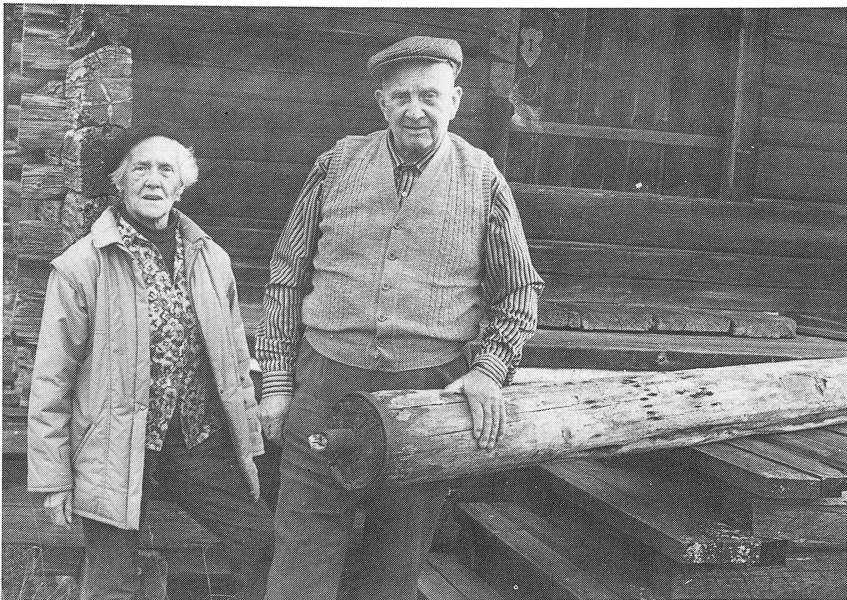
Jons Anders Persson och hustrun Alice förevisar en del av den vattenledning som "Lill Per" tillverkade.
