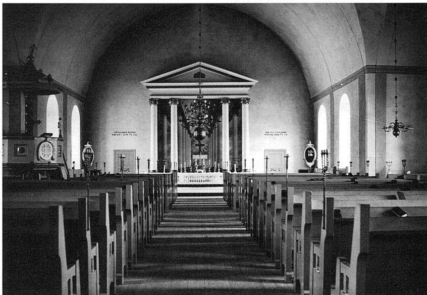
Interiör från Sollerö kyrka 1917 efter det att golvhöjning skett men innan elektrisk belysning installerats.
