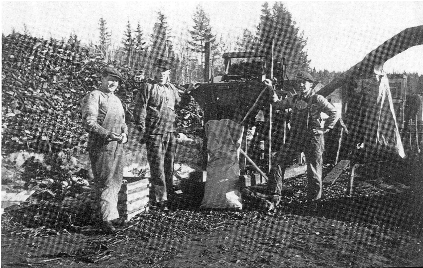
De utrivna kolen krossades i den specialbyggda kolkrossen som drevs av epatraktorn. Kolen packades i hektoliterssäcken. Göte Bäck i mitten.
