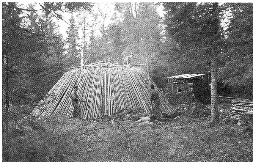
Resmilu med tremetersved. Göte Bäck (t.h.) laggar sista kolvedstören till milan. Återstår sedan att stybba milan. Efter cirka två veckor var milan klar att rivas. Kortare tid gav samre kol. Kolarkojan brukade byggas nära milan. Foto 1942.
