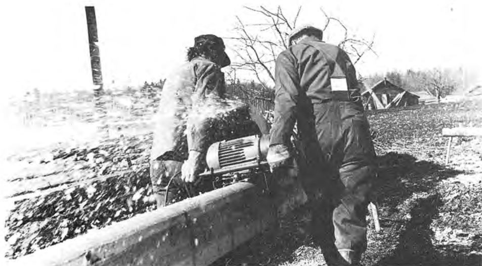
Här jämnhylas stockens över- och undersidor med en eldriven kutter.
