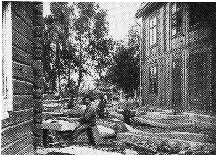
Stenhuggare Flintull Anders Andersson (Filén) från Gruddbo tillverkar trappan till Elias Lindhés nya affärshus, nuvarande Konsum. Till vänster sockenstugan. 1908. Foto: Johan Ohman.
