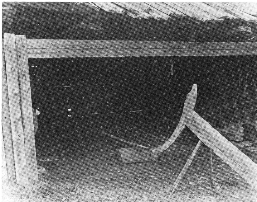
Gammelt båtlider hos Knuts Jöns Märtensson i Bodarna. Kölen har sträckts och stammarna resta. Utanför detta båtlider har en del av skutorna (se artikeln) byggts.
