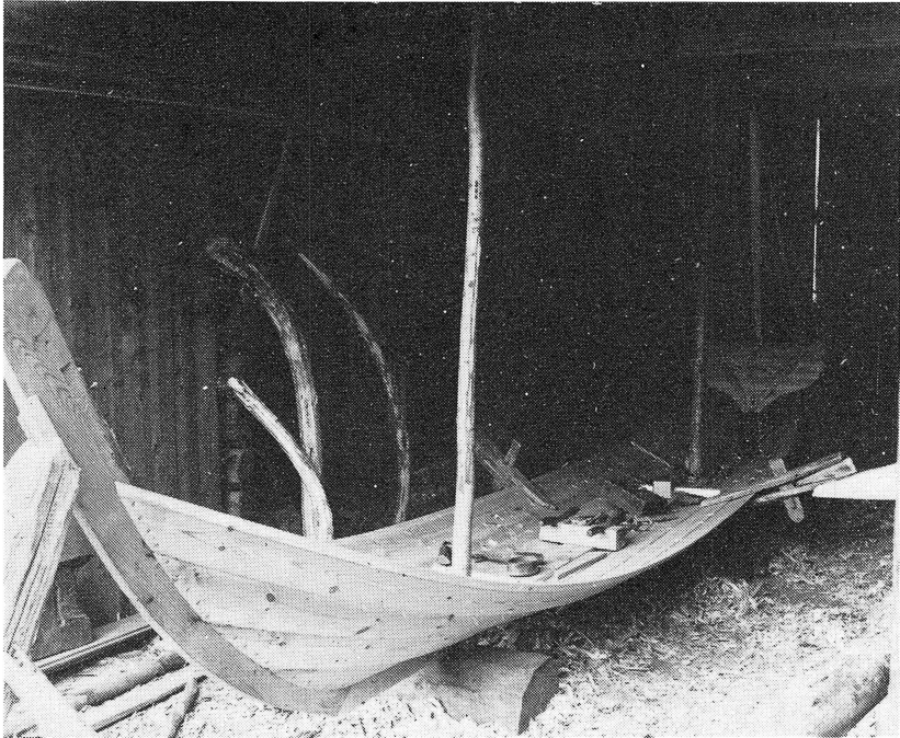
Påbörjad båt med "rångger" resta mot väggen i lidret. Denna båt byggd med "tverbak" av Trapp Jöns Olsson, Gruddbo.
