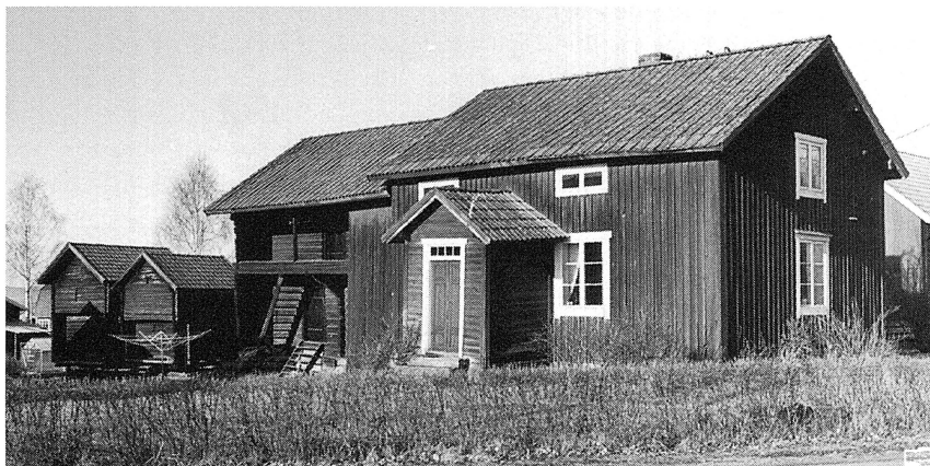
Lafvasgården i Häradarvet med hopbyggt bostadshus och lofibod. Bostadshuset är en enkelstuga med en i senare tid tillkommen övervåning. De två gavelhärbrena hör till gården. Foto: Mats Persson 1992.
