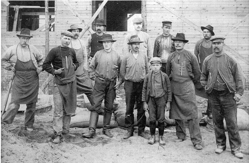
Tidigt arbetsplatsfoto. Okänt var. Filén nr tre från vänster
